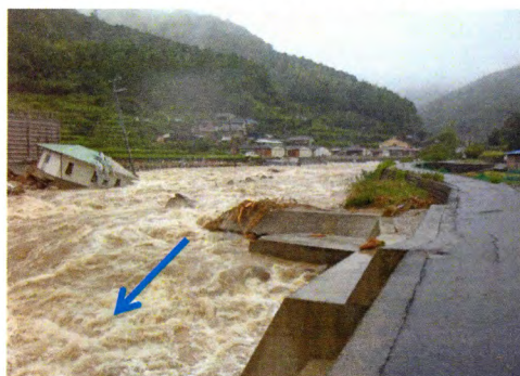
二級河川井戸川（熊野市）の復旧状況
