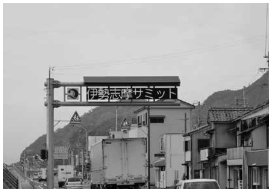
国道42号 電光掲示板
