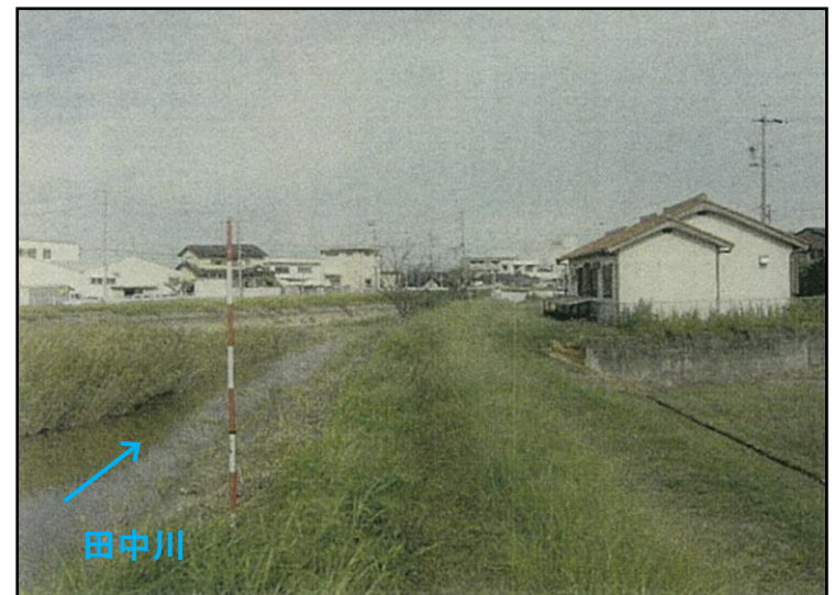
田中川右岸の越流箇所（翌日撮影）
