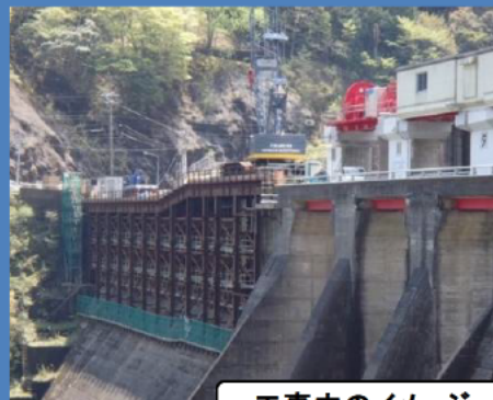
工事中のイメージ ※1号ゲート工事中の写真
