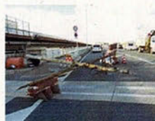
【老朽化により倒壊した信号柱(県外)】
