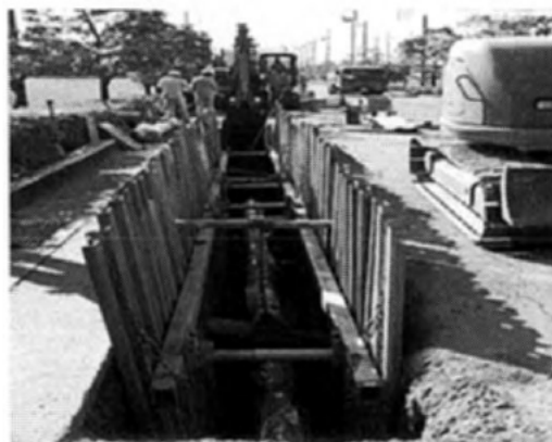
管路布設替えの状況
