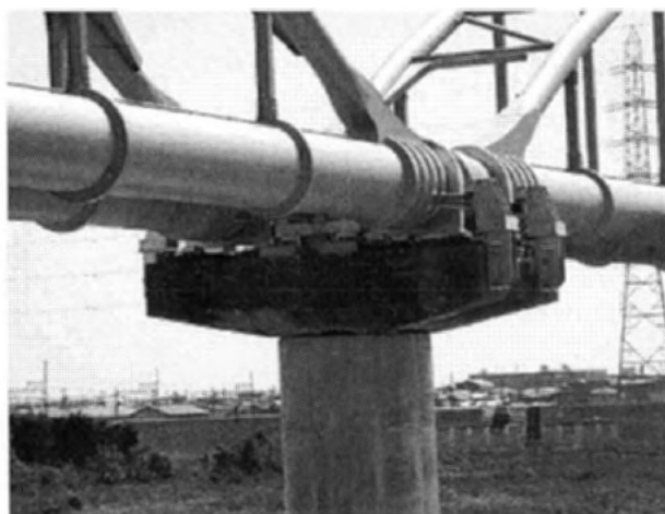
鈴鹿川第2水管橋の耐震化
