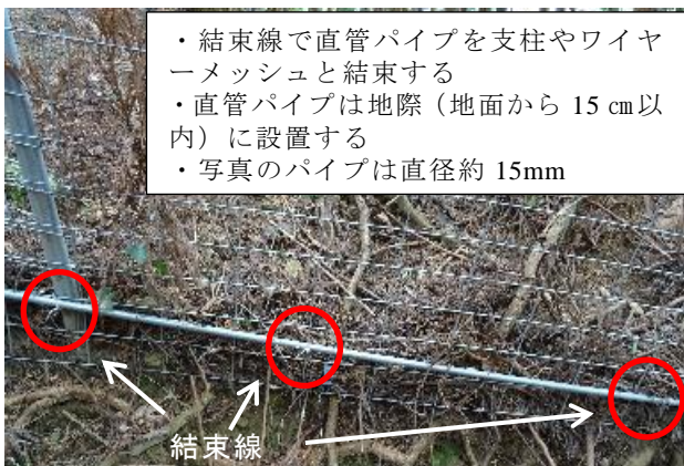
図3 直管パイプで下部を補強されたワイヤーマッシュ柵の例
