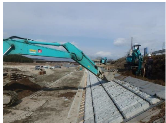
一級河川 木津川 (伊賀市)
