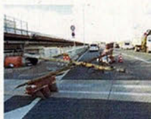
【老朽化により倒壊した信号柱(県外)】
