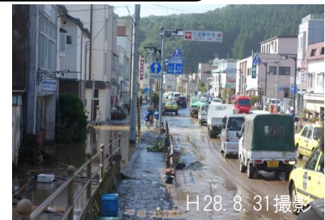
久慈市内 被害状況
