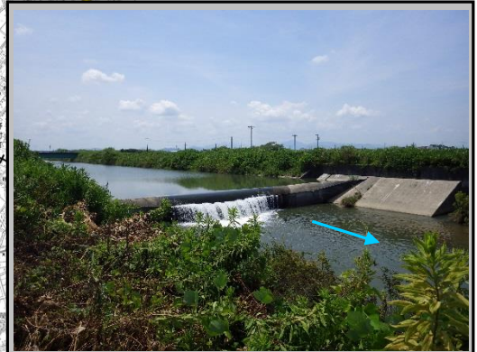
④【中流域】3.9k付近 ゴム堰 魚道あり(起立時)
