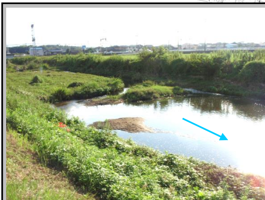
⑥【中流域】6.6k付近 落差工
