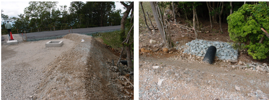
沈砂マスの完成状況（平成28年6月15日）
