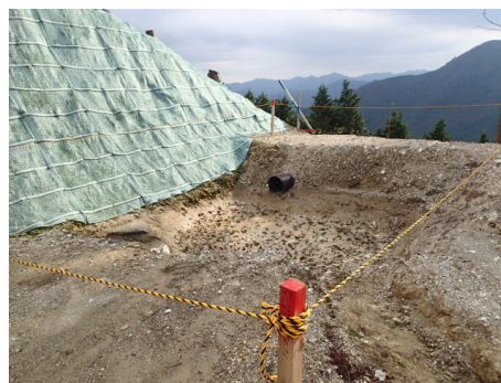
沈砂マスの仮設状況（平成27年10月6日）
