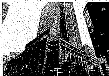
日本橋三井タワー
