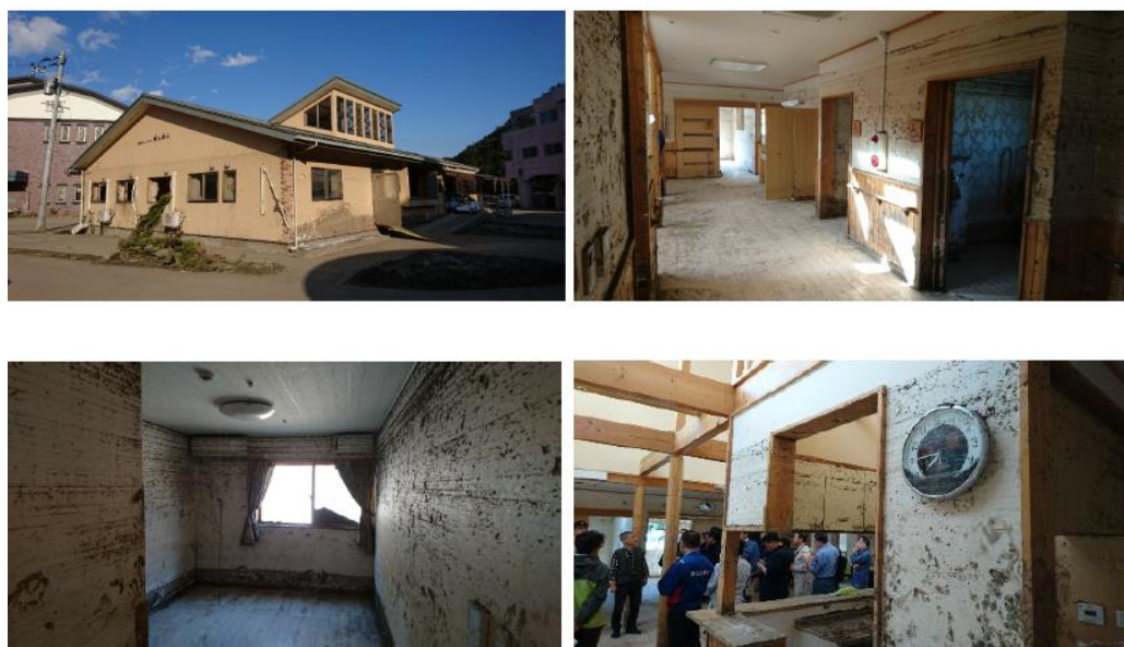
被災した高齢者福祉施設の様子
