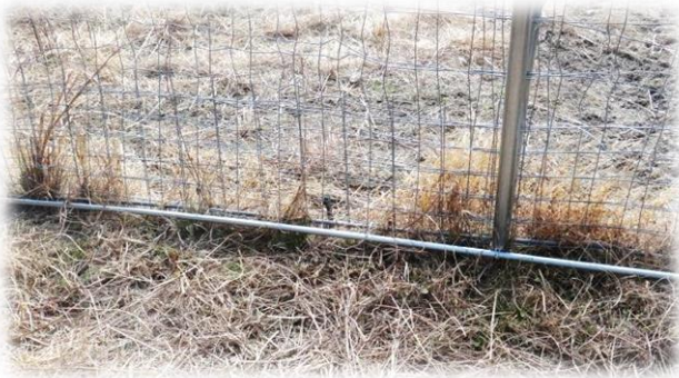
直管パイプによる補強
