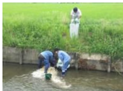
排泥施設にたまった泥の排出
