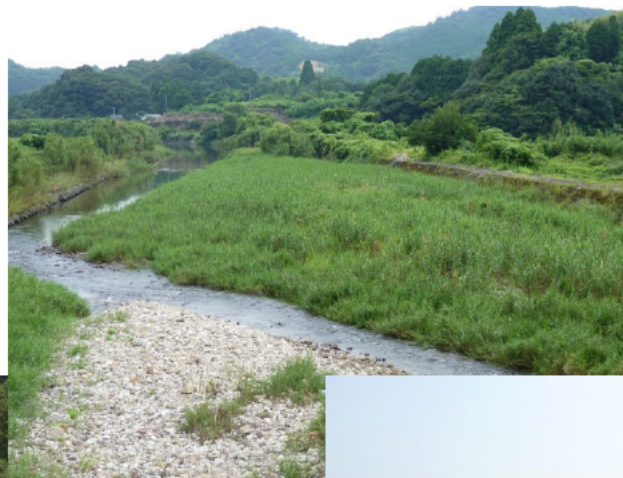
二級河川尾呂志川 堆積土砂撤去
