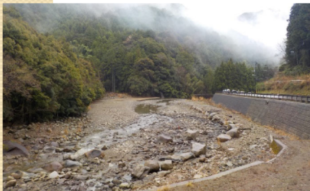
二級河川井戸川 堆積土砂撤去
