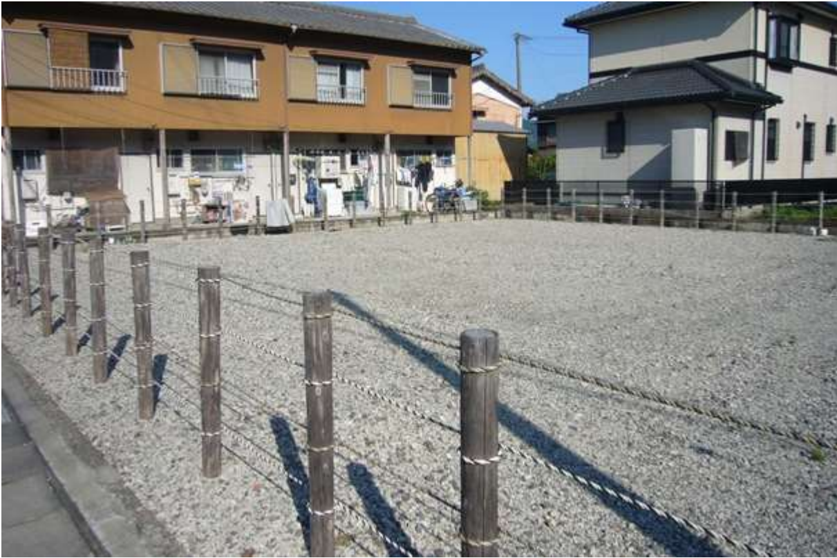
○旧長島高等学校職員住宅（長島教 12 号の 1～6）敷地
