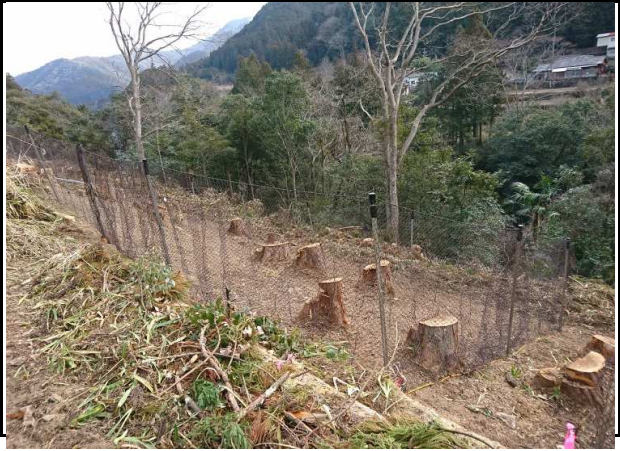
写真1 防鹿柵設置状況
