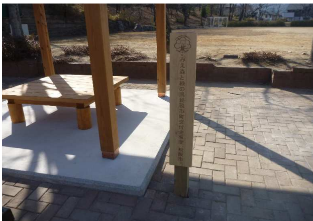
写真5 PR標柱設置状況
