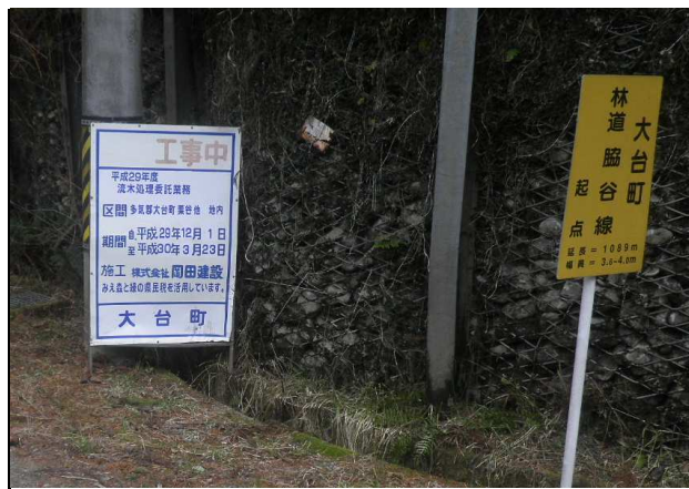
写真6 実施中 工事用看板に税のPRを掲載している
