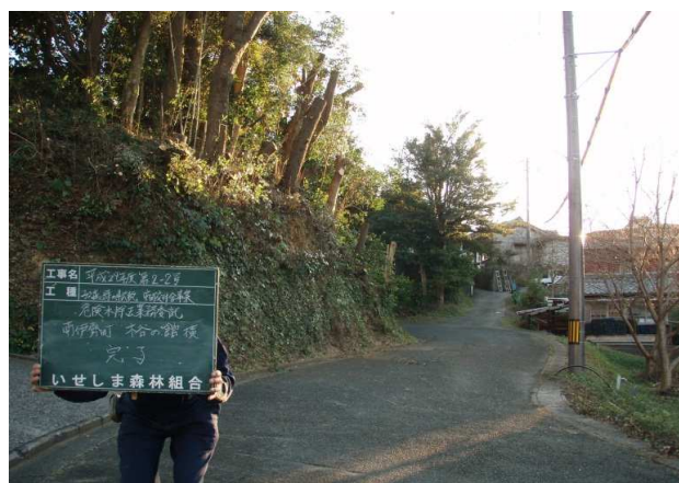
写真4 危険木除去(木谷) 実施後 倒木の危険がなくなり、安全に安心して通学出来るようになった。
