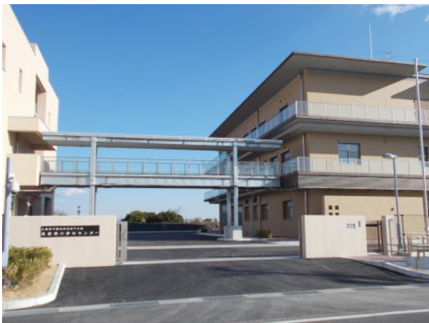
志登茂川浄化センター
