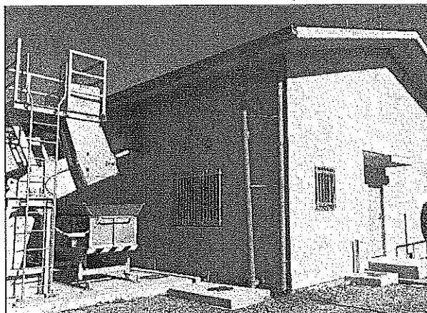
新設された阿児排水機場
