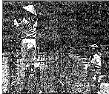
シカの飛び越え防止のため電気柵を増設
