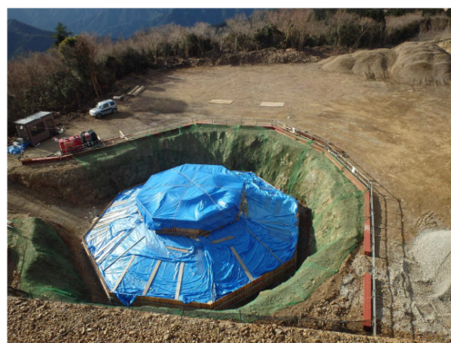
写真 2.3.1-2 第2期工事中の状況 (平成30年2月時点)
