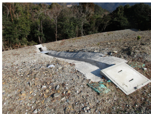
写真 2.3.1-1 第1期工事で完成した沈砂マスの状況 (WT-1 沈砂マス)
