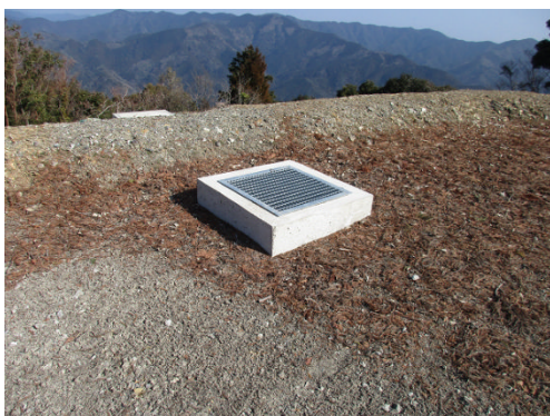
写真 2.3.1-1 第1期工事で完成した沈砂マスの状況 (WT-1 沈砂マス)
