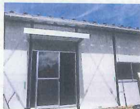
【建設中の仮設住宅】
