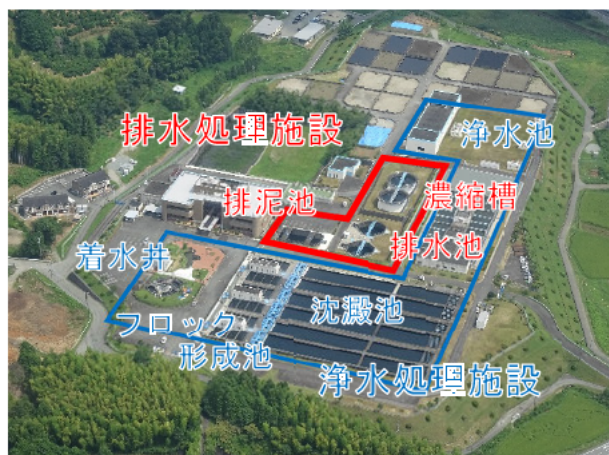
排水処理施設
