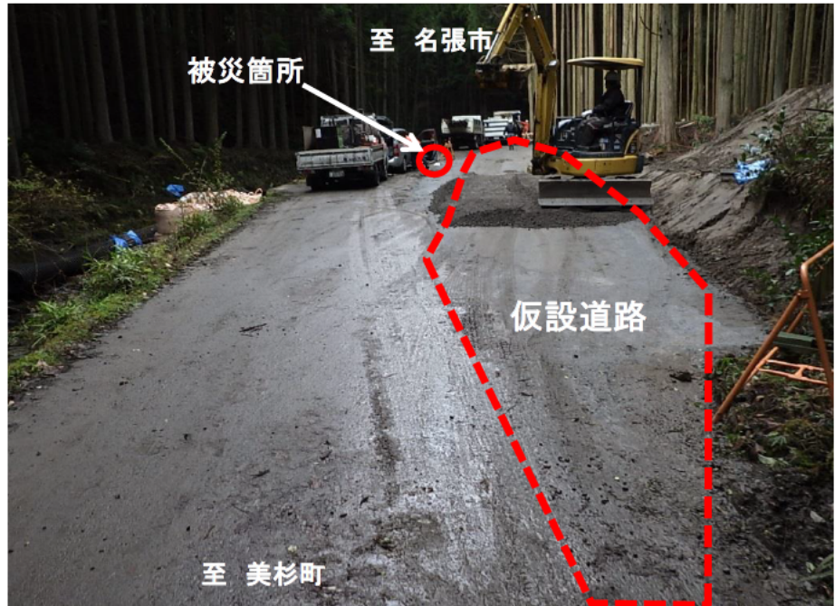
仮設道路設置状況 撮影日：平成30年12月24日
