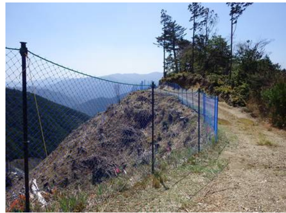
植栽地への防護柵の設置（松阪市）
