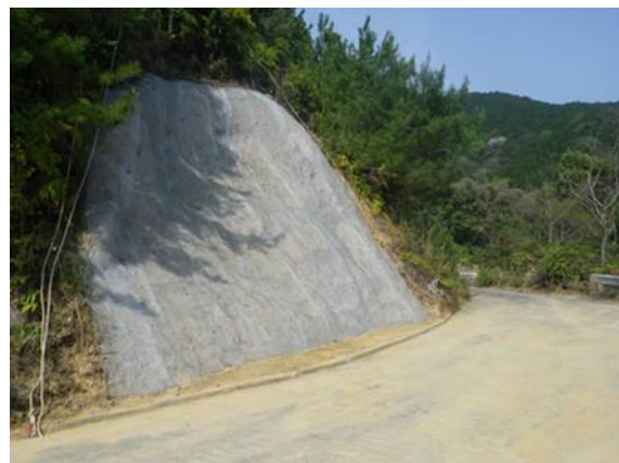
林道三和片川線 復旧状況（熊野市）
