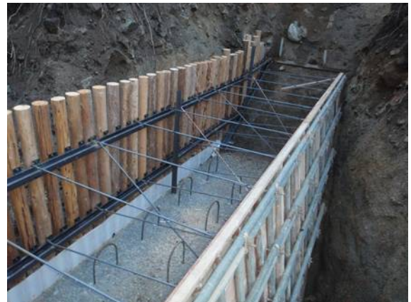
公共工事等の利用事例 間伐材型枠（津市）
