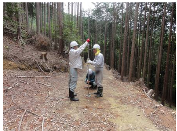
森林作業道の路体支持力の調査
