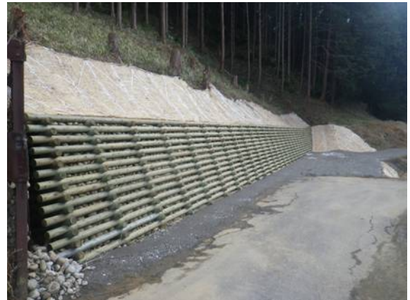
公共工事等の利用事例 木製土留工（津市）
