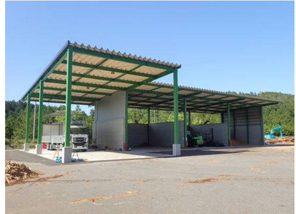
木質チップ加工施設の整備（伊賀市）
