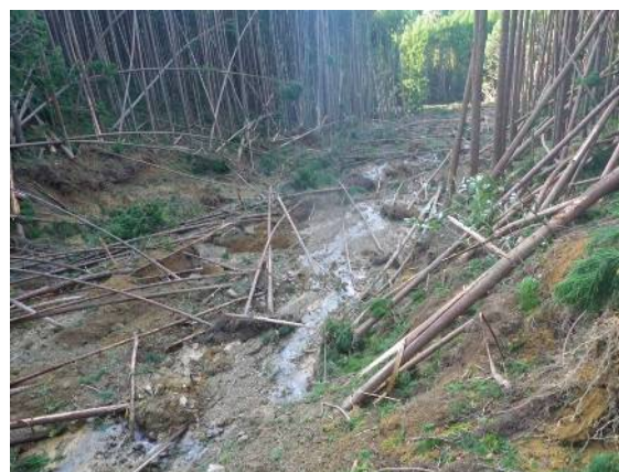
台風第21号による林地の被災状況（大紀町）
