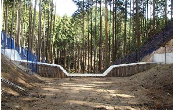
公共工事等の利用事例 間伐材型枠（四日市市）
