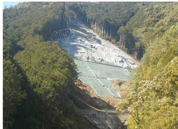
治山事業 復旧状況（紀北町）
