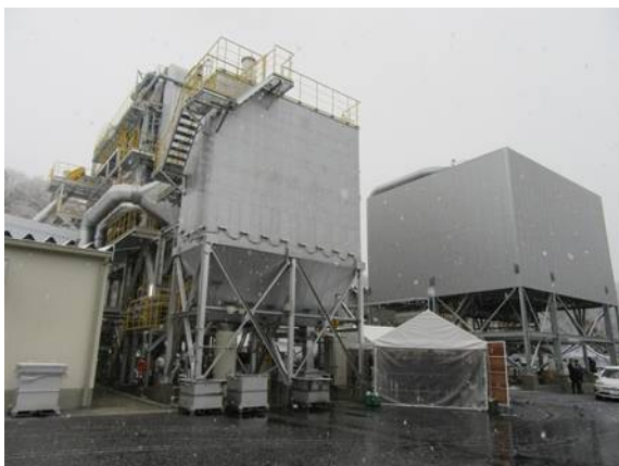
バイオマスパワーテクノロジーズ 松阪木質バイオマス発電所（松阪市）
