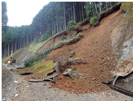
6月の豪雨による林道施設の被災状況（熊野市）
