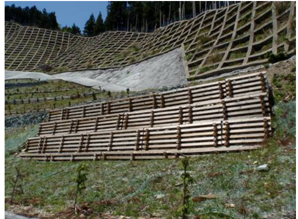
公共工事等の利用事例 木製土留工（松阪市）
