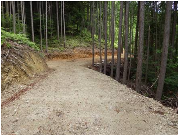
森林作業道の開設（大台町）
