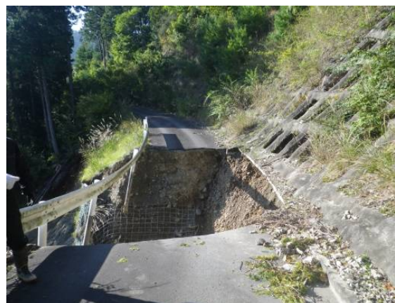
台風第21号による林道施設の被災状況（松阪市）
