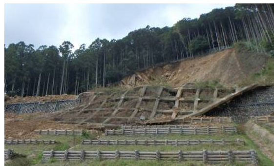
台風第21号による治山施設の被災状況（御浜町）
