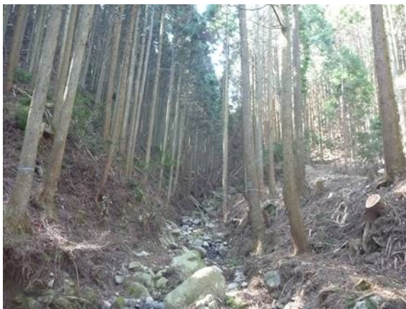
災害緩衝林の整備【整備後】（津市）
