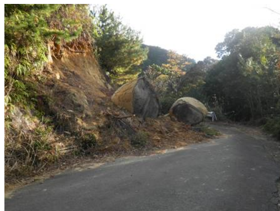
林道三和片川線 被災状況（熊野市）
