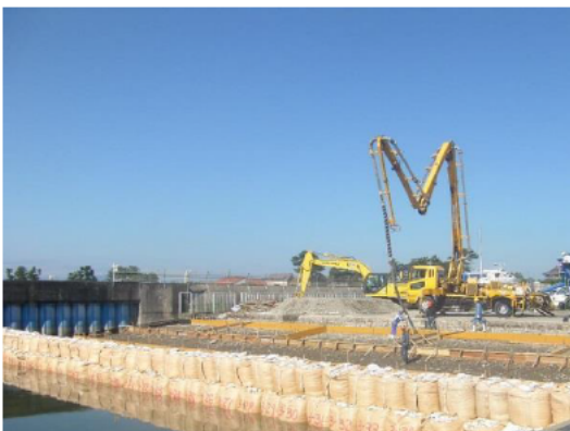
重要港湾 津松阪港 (津市)
