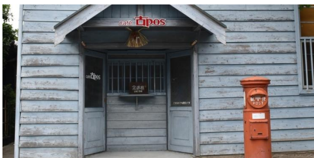
旧一志波瀬郵便局 正面（東から）
