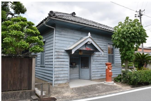
旧一志波瀬郵便局 外観（東から）
