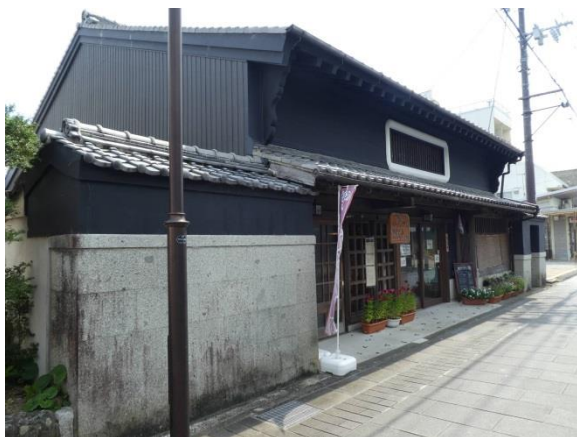
熊野古道おもてなし館 外観（熊野街道側）
