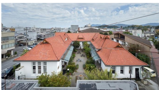
旧山田郵便局電話分室 西側外観(西から)
