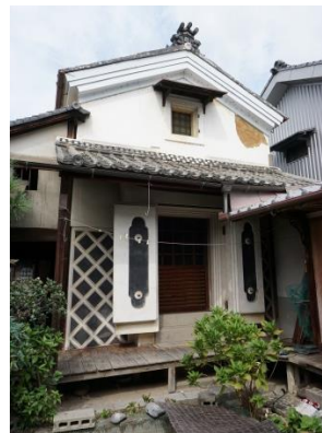
山中家住宅 北蔵 (東から)
