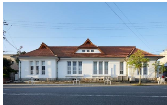
旧山田郵便局電話分室 北側外観(北から)
