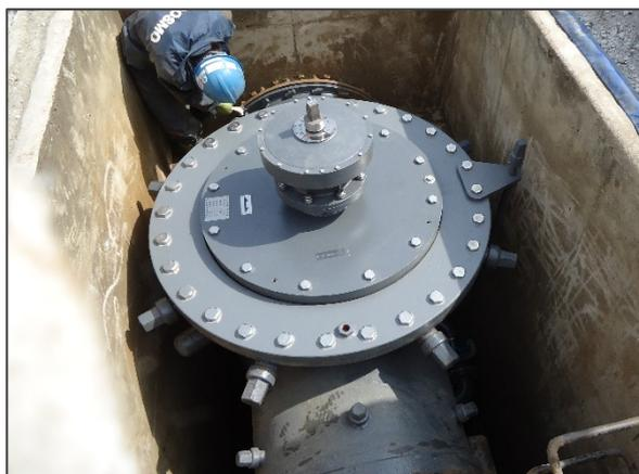
φ 800 制水弁工事（不断水工設置状況）
