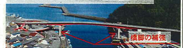
【地震対策】長島港（江ノ浦大橋）
