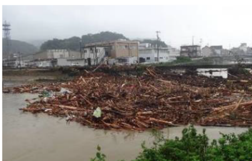
橋梁に押し寄せた大量の流木
