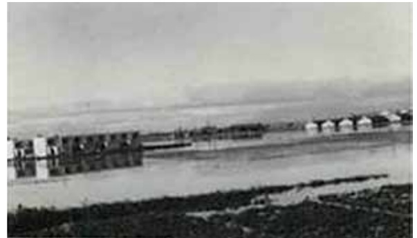
図 3.4-2 昭和 34 年伊勢湾台風の浸水状況（四日市市楠町）
