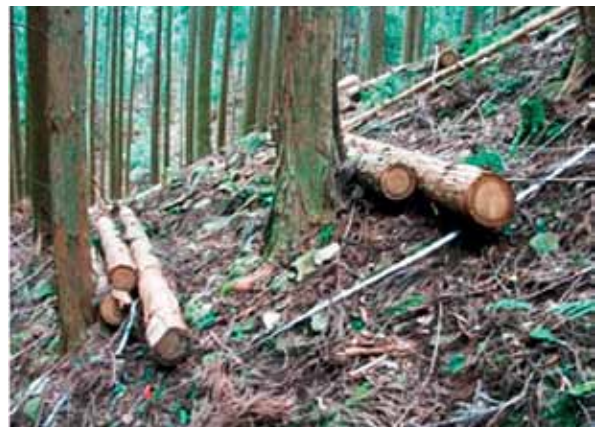
図 3.4-5 災害緩衝林整備事業実施状況 伐倒木を利用した土砂止め
