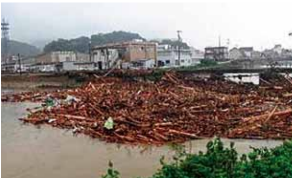
図 3.4-3 2011年9月紀伊半島大水害 橋梁に押し寄せた流木（熊野市）
