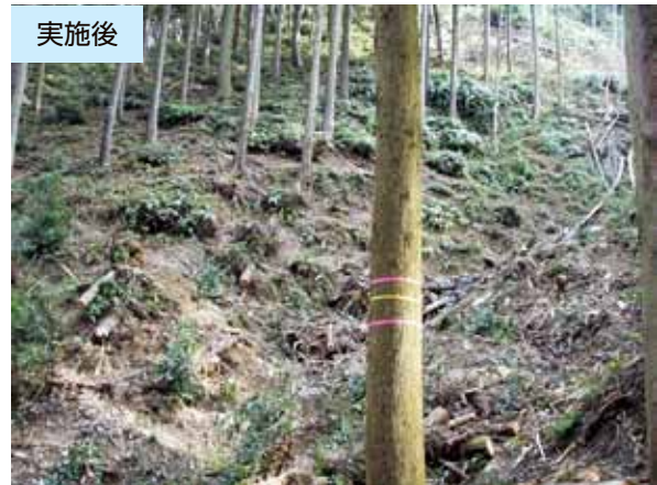
図 3.4-4 災害緩衝林整備事業実施状況 上：実施前 下：実施後
