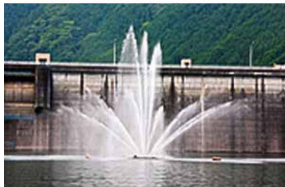
図 3.2-1 蓮ダムの表層曝気循環装置（噴水）
