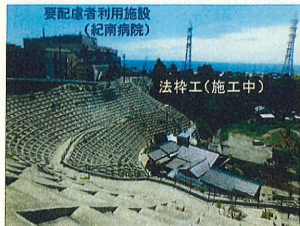
●急傾斜地崩壊対策事業（阿田和地区：御浜町）
