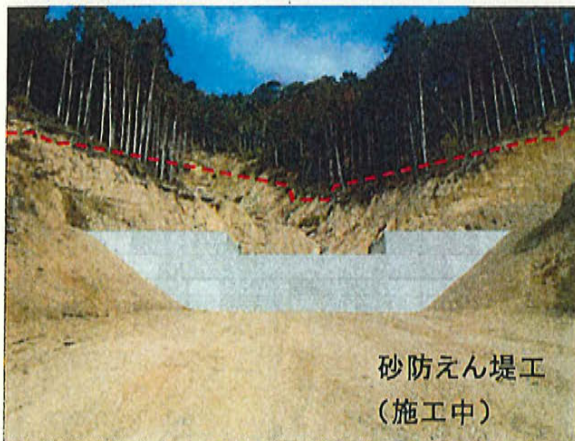
●通常砂防事業（長谷：多気町）
