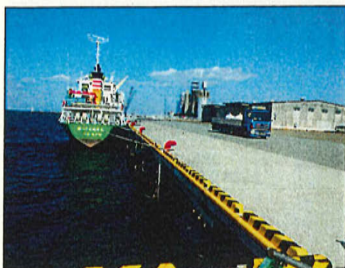
岸壁棧橋上部の更新
