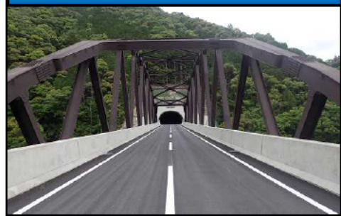
④新西谷橋(土場バイパス)
