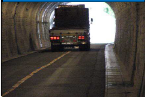
①車両対向困難なトンネル(現道)
