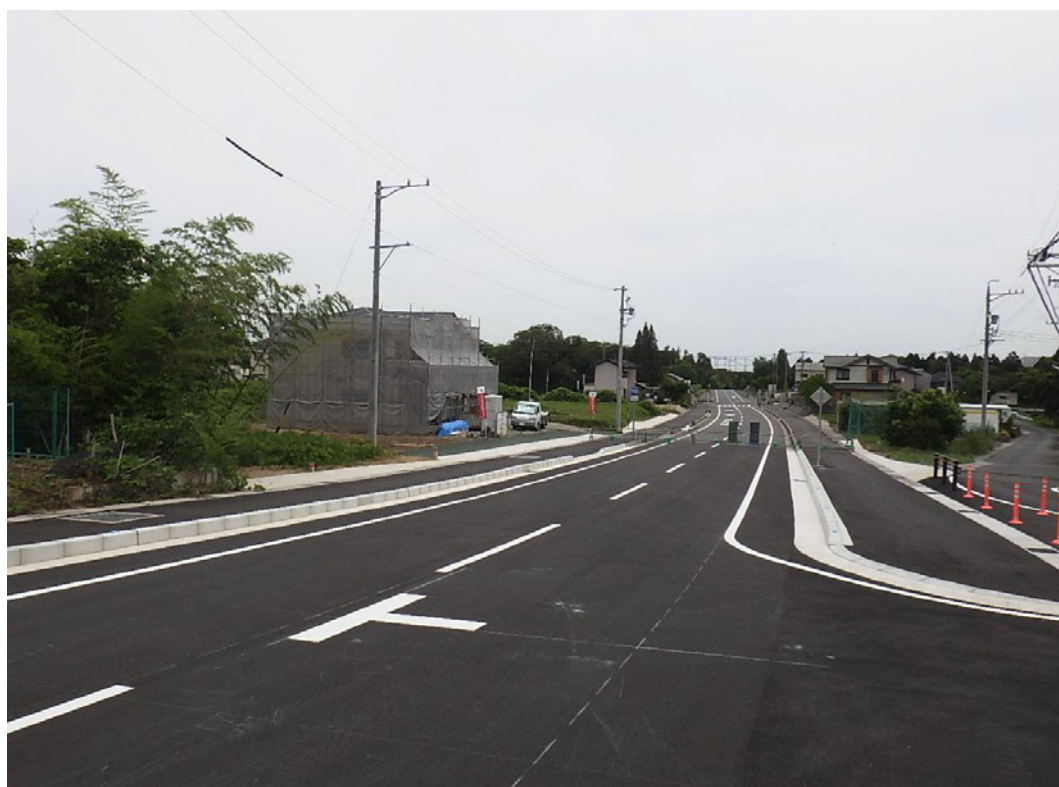
供用開始箇所(工事後)
