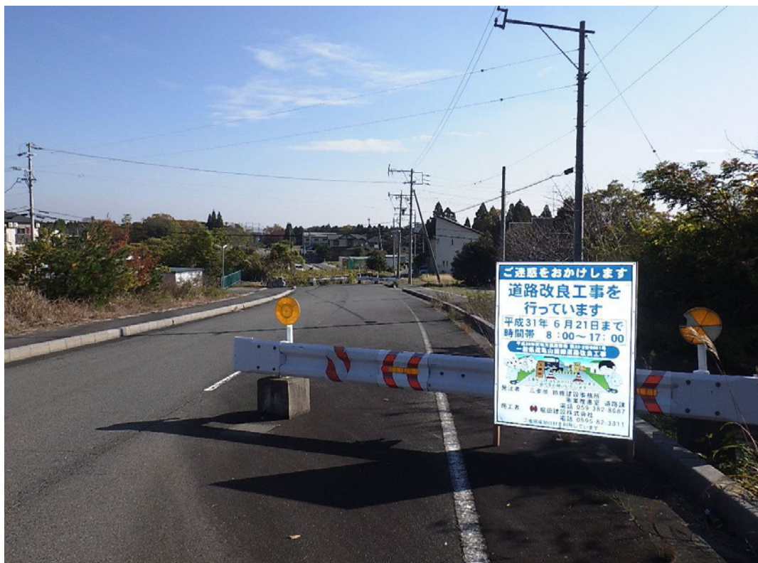
供用開始箇所(工事前)
