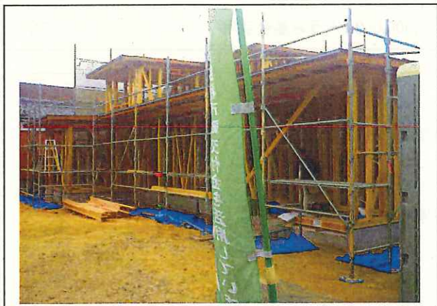
写真1 久居中町 個人住宅 上棟(外観)
