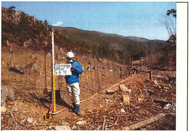
写真4 植栽地における防鹿柵設置状況
