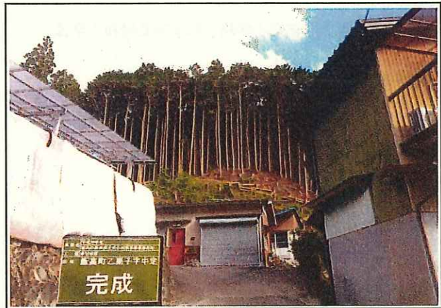
写真4 森林整備(支障木伐採 写真3の完成) 人家に樹木が倒れる恐れがある
