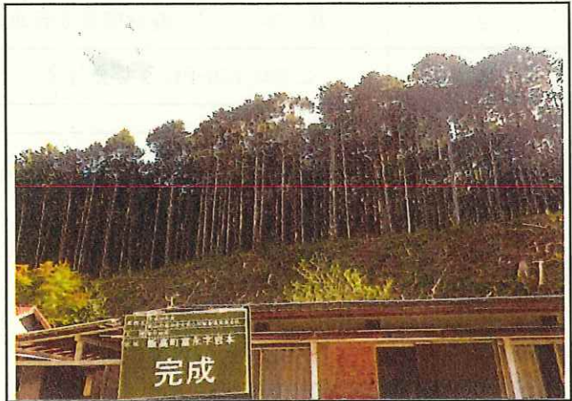
写真2 森林整備(支障木伐採 写真1の完成) 人家に樹木が倒れる恐れがある
