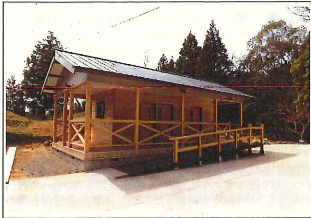
写真2 トイレ及びスロープ
