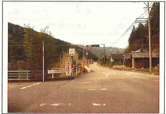
写真2 伐採箇所(施工後状況①)
