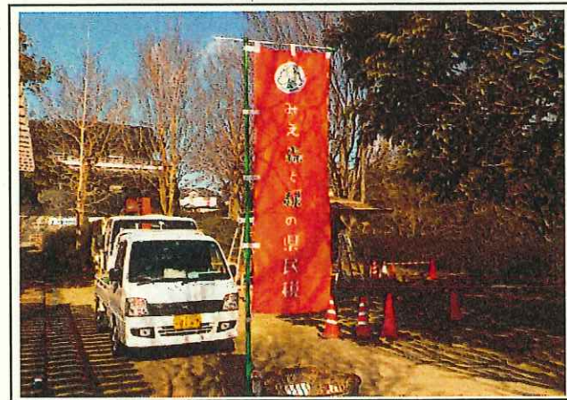
写真5 施工中 啓発のぼり設置状況
