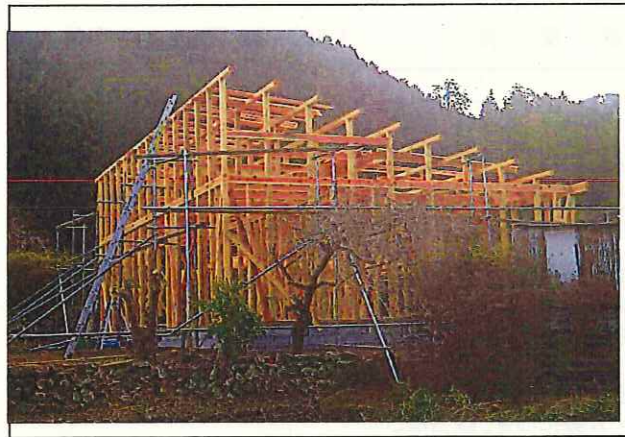
写真2 美杉町上多気 個人住宅 上棟(外観)
