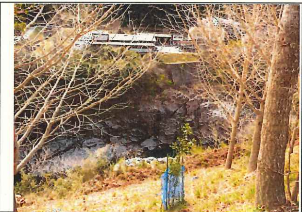
写真3 伐採箇所(施工後状況②)
