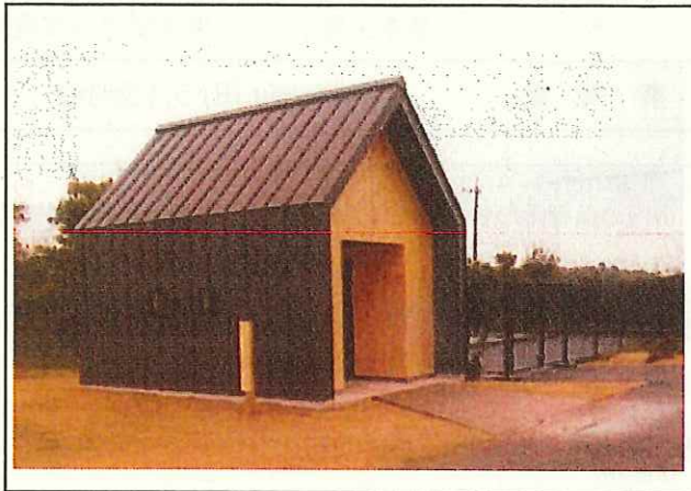
写真2 屋外トイレ完成写真 外観その2 農業公園ベルファーム
