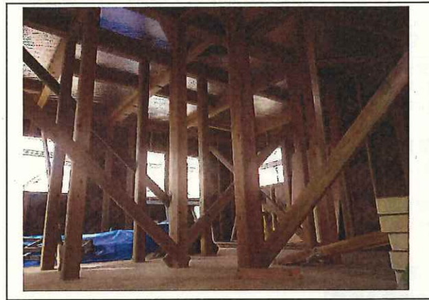
写真4 久居藤ヶ丘 個人住宅 上棟(内観)
