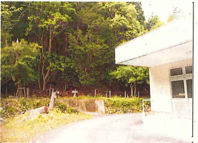
写真6 崎地内その1大紀中学校危険木除去後
