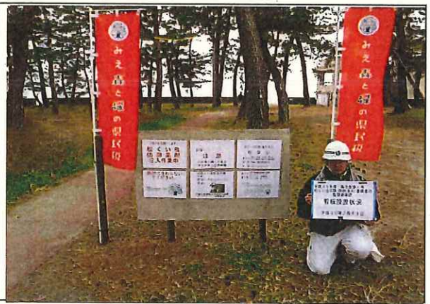
写真5 作業中看板設置状況
