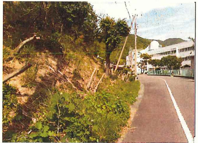
写真2 錦地区人通学路危険木撤去後
