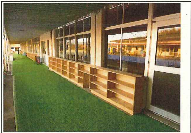
写真6 外城田保育所下駄箱 施工後
