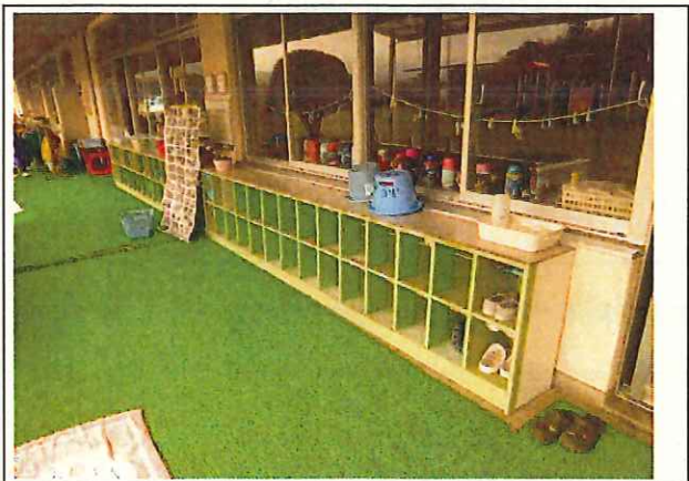
写真5 外城田保育所下駄箱 施工前
