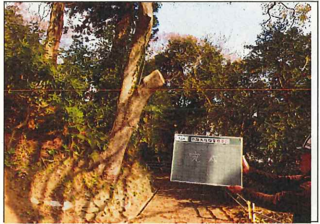
写真2 作業後(三丁目)
