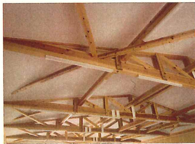
写真5 完成(内部)大会議室
