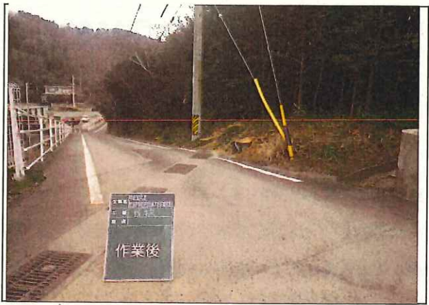
写真2 作業後(安楽島小学校)
