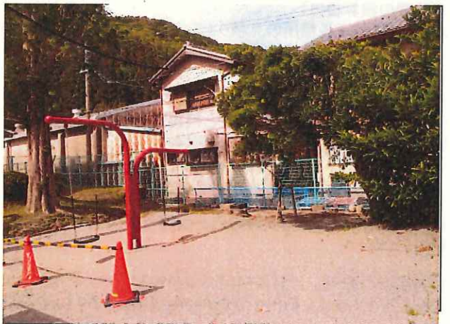
写真4 錦小学校危険木除去後
