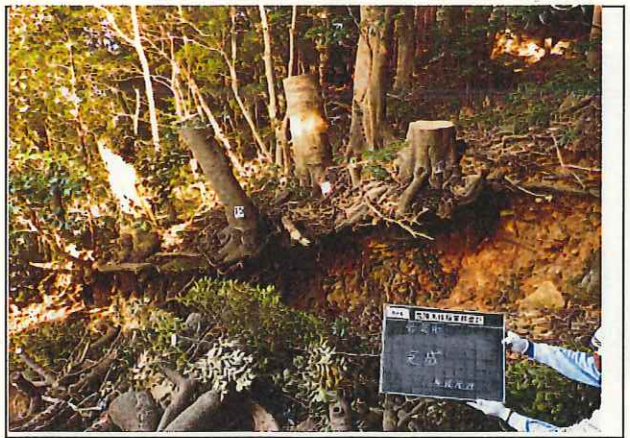
写真6 作業後(岩倉町)
