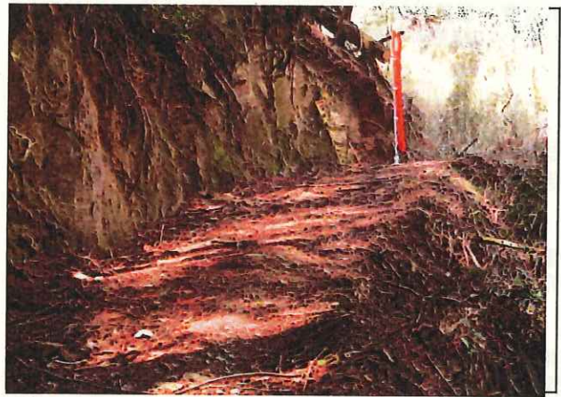
写真4 林道整備による倒木除去
