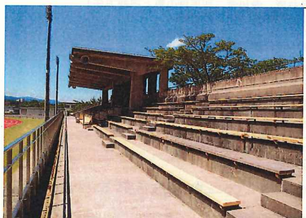
写真4 メイハンフィールド 着工後
