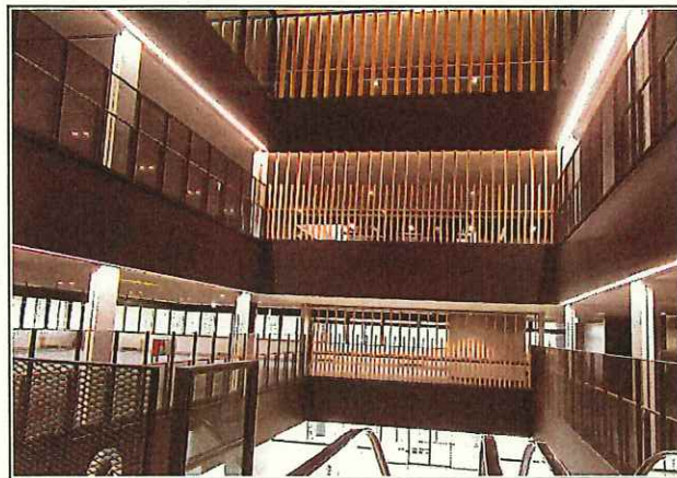
写真3 木製縦ルーバー
