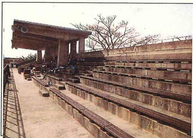
写真3 メイハンフィールド 着工前
