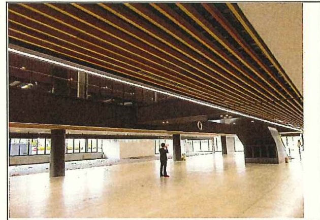
写真6 天井ルーバー
