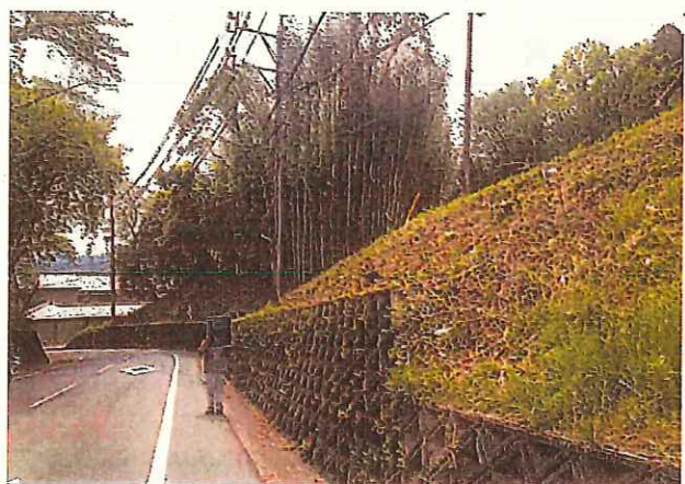
写真2 通学路整備完了【市道里緑が丘線】
