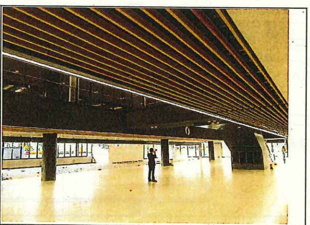
写真6 天井ルーバー
