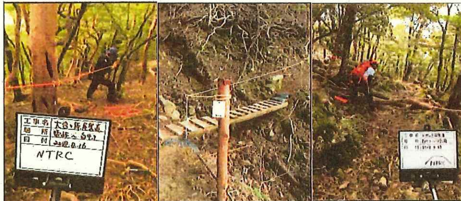
写真4 【実施中】 ガイドロープ設置
