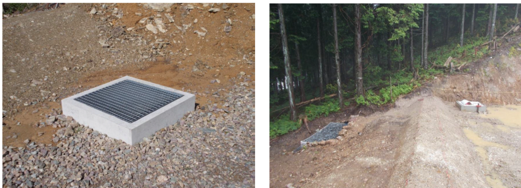
写真 2.1.1-1 2期工事で完成した沈砂マスの状況
