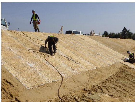
写真 2-1-1 わら芝張りの施工
