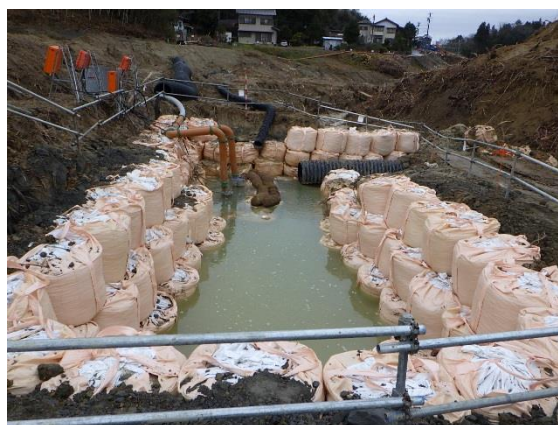
写真 2-1-2 濁水処理プラント
