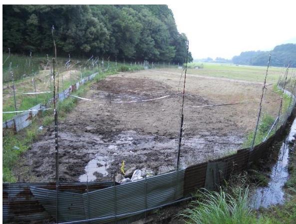
写真 2-3-3 移植地 A 整備直後
