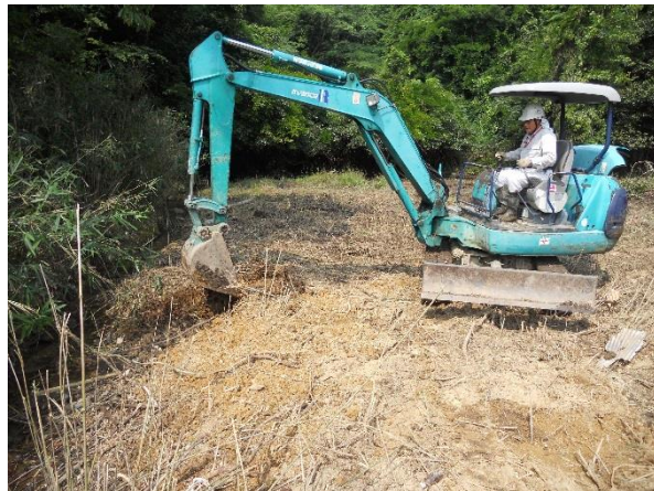
写真 2-3-8 移植地 B 整備中 (土工事)
