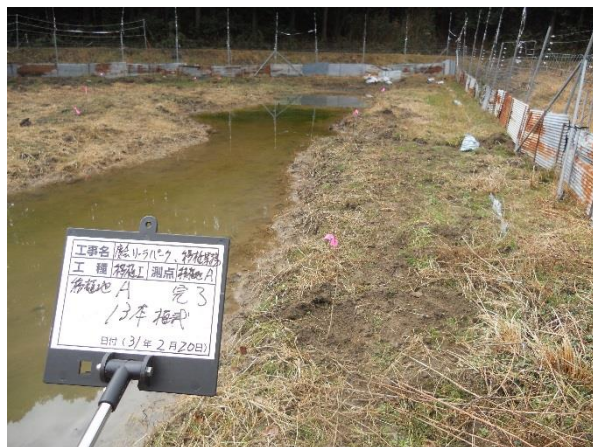
写真 2-3-6 移植地 A 植栽完了
