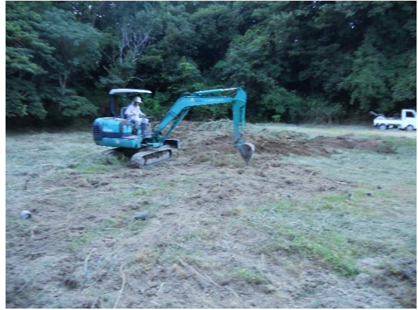
写真 2-3-14 移植地 C 整備中 (土工事)
