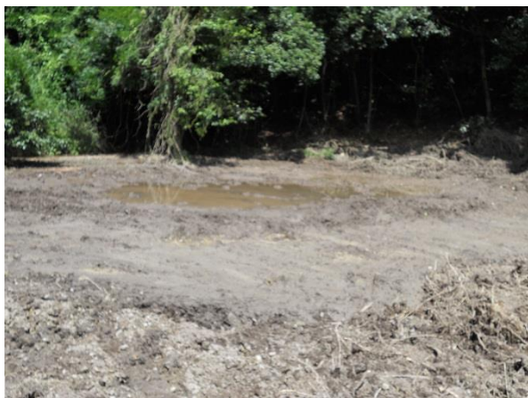
写真 2-3-9 移植地 B 整備直後
