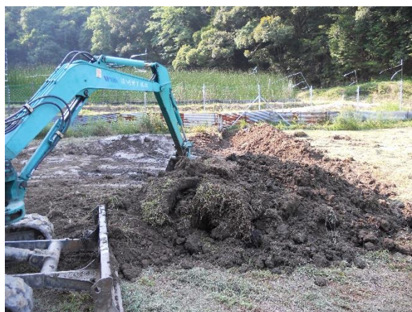
写真 2-3-2 移植地 A 整備中（土工事）
