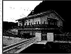
集落排水施設
