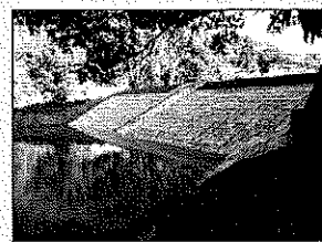
防災施設整備
