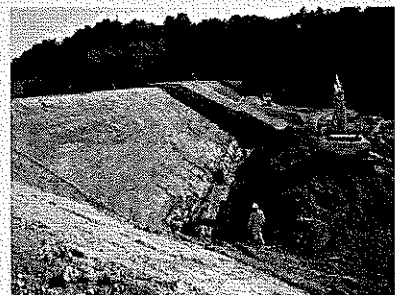
堤体工（前刃金工法）
