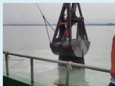
大型台船による施工風景
