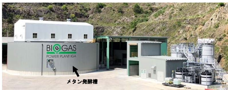
図1 バイオガス発電施設
