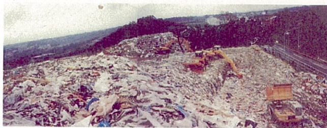
(参考：対策工事前の状況 [平成10年])
