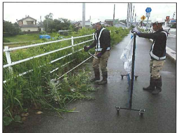
道路の除草作業（松阪市）
