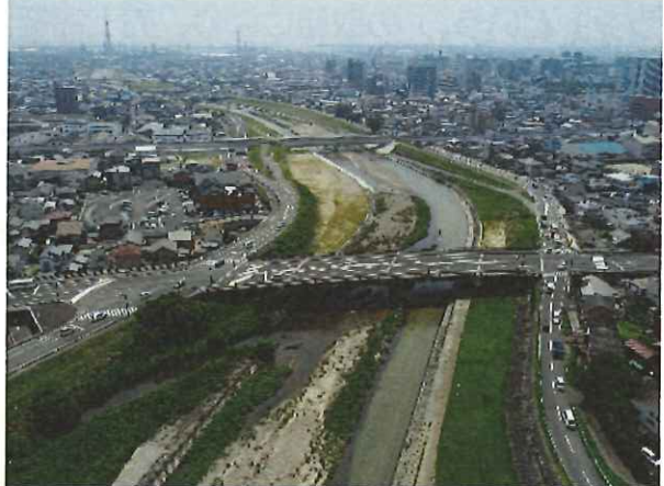
三滝川河川改修事業（四日市市）
