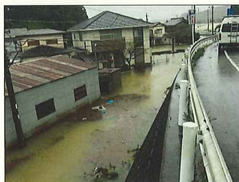
台風第19号による浸水状況 伊勢市楠部町地内（矢田川）
