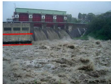
三瀬谷ダムの放流状況
