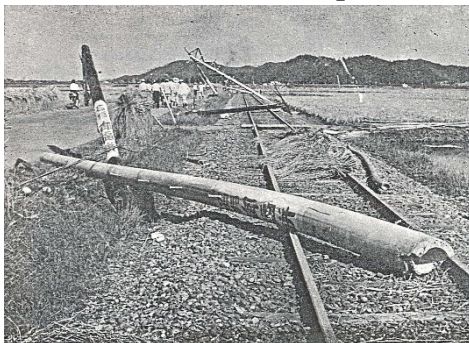
伊勢市内の被災状況
