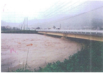
あそ 阿曾大橋上流の右岸堤より あそ 阿曾大橋を望む
