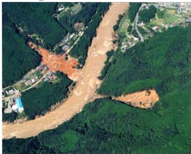
滝谷地区の斜面崩壊
