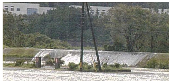
被災状況(上野地区から右岸堤防を望む)
