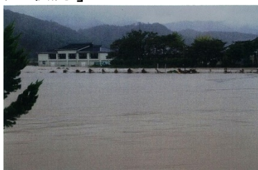
あそ 阿曾大橋脇地域交流センター浸水状況
