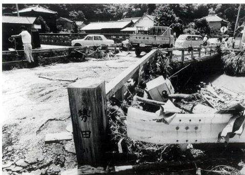
勢田川姫之橋の被災状況
