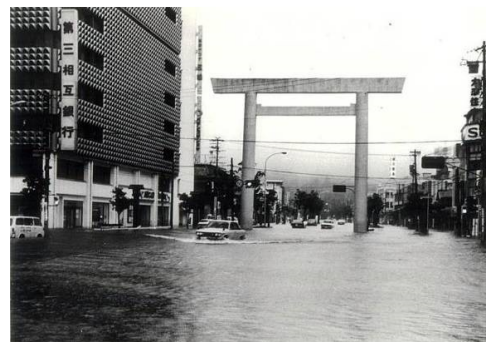
伊勢市駅前の浸水状況
