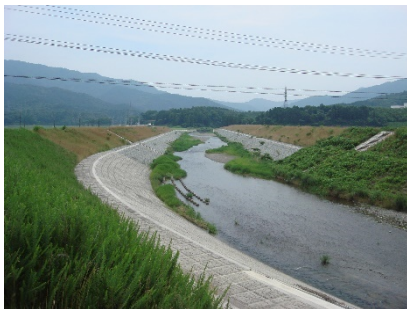
横輪川 改修後の河道状況
