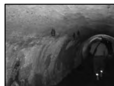
対策工事実施前
