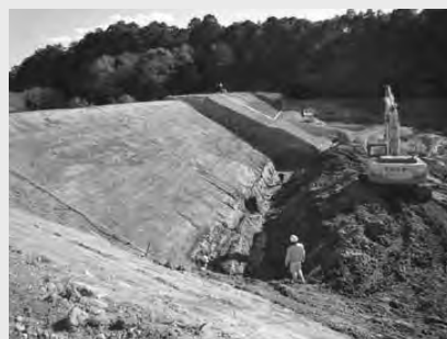
堤体工（前刃金工法）
