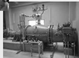
（排水機場の更新）
