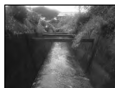
対策工事実施前
