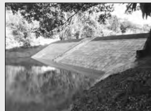
防災施設整備
