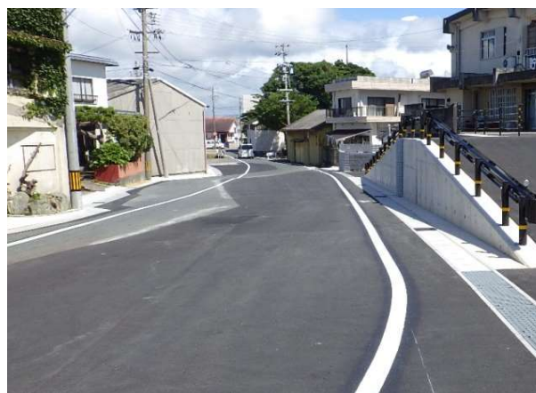
整備状況（現道拡幅区間）
